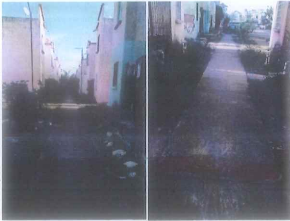
Ilustración 6 Callejones entre los edificios del fraccionamiento
