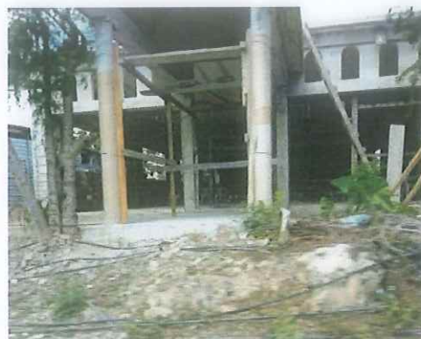
Ilustración 17.-Obras en construcción
